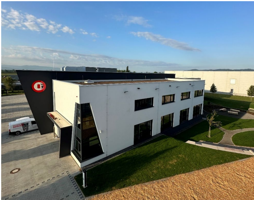
Neubau der Alexander Bürkle panel solutions GmbH in Malterdingen
